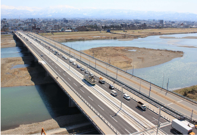
富山大橋：呉羽町袋線（富山市）
