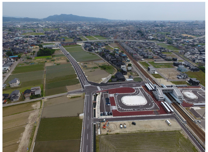
完成した高岡新駅停車場線（高岡市）
