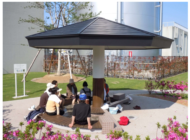
下水道バイオガスを熱源として利用している 足湯「ばいお〜ゆ」(黒部市)
