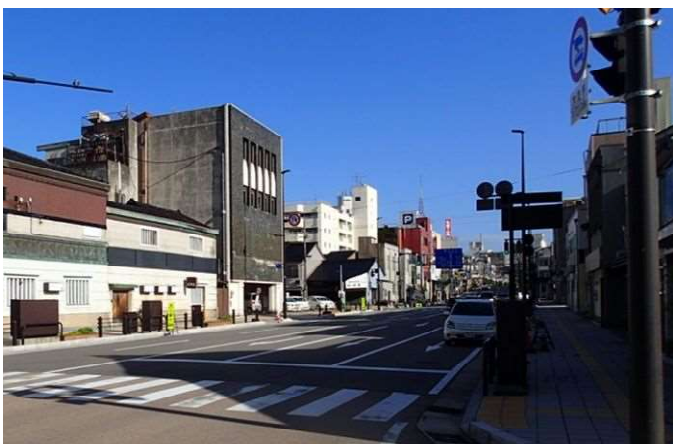
電線類が地中化された高岡駅佐加野線（高岡市）
