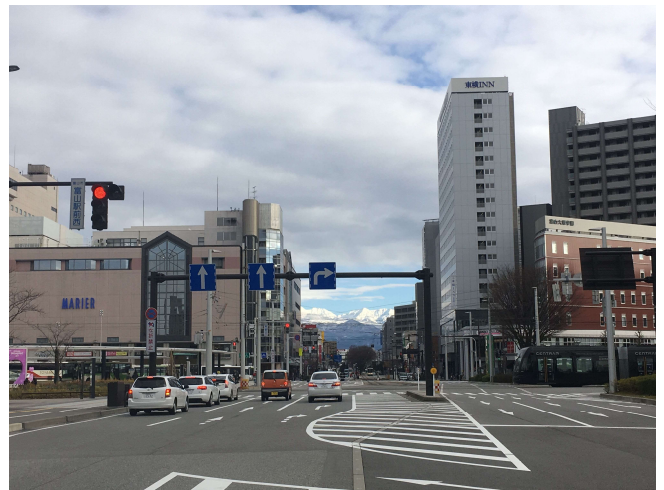
幹線街路「富山駅西線」(富山市)
