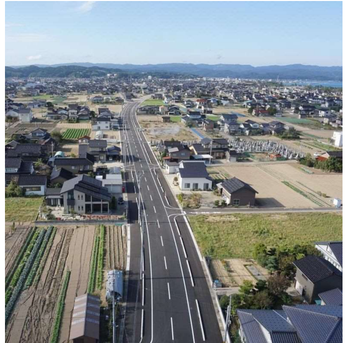
完成した氷見伏木線（氷見市）
