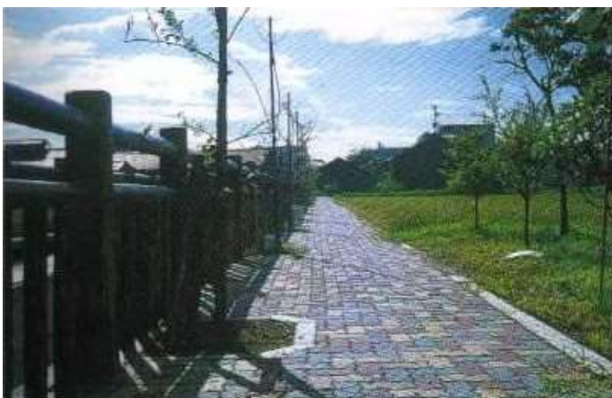
溶融スラグを利用したインターロッキング (南砺市)
