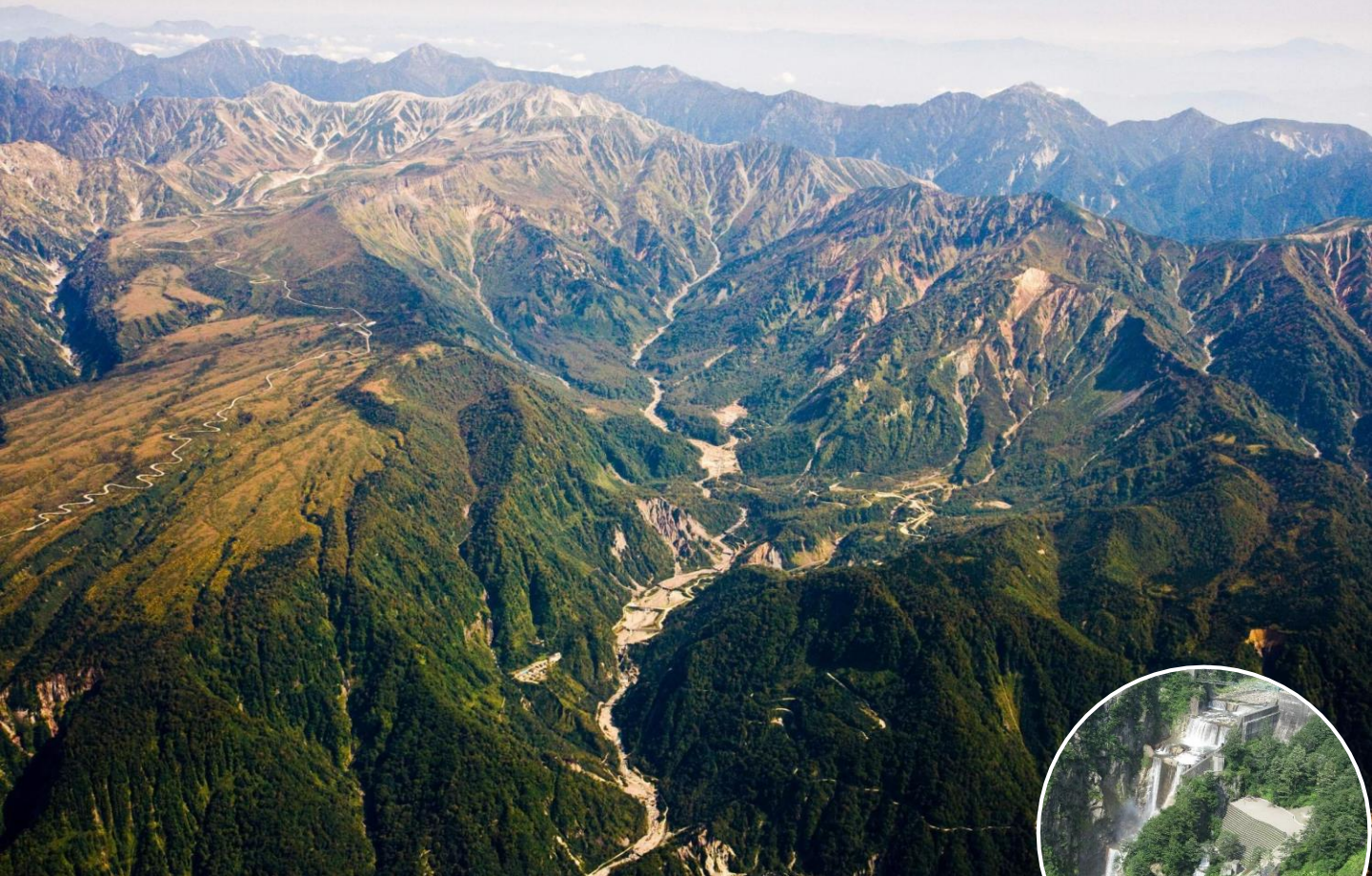
白岩堰堤 (重要文化財)
